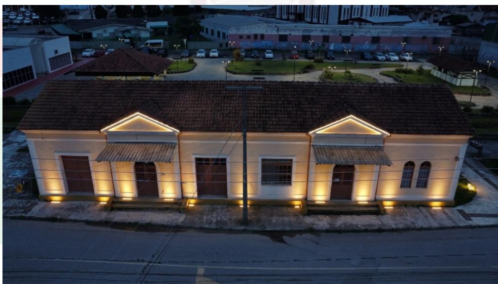
Figura 22 - Fotos visuais da Estação Ferroviária - Depois
