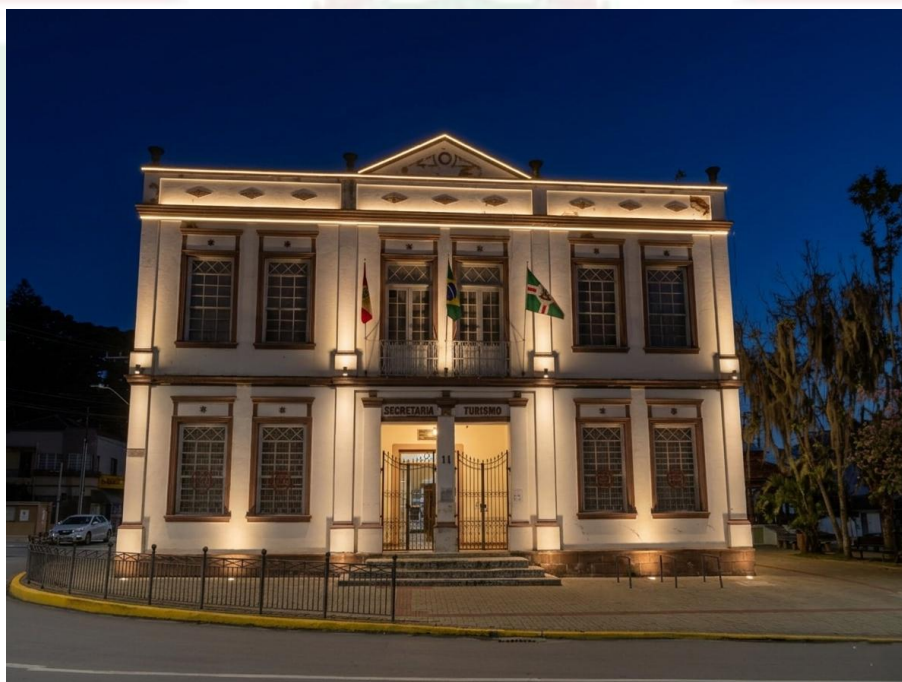
Figura 20 – Fotos visuais do Prédio do Departamento de Turismo - Depois
